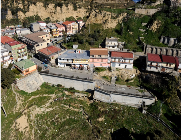
Fig. 2 Cirò landslide crown
